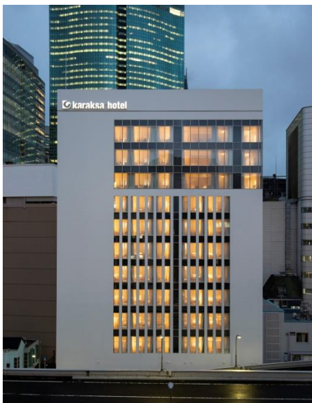
からくさホテルプレミア東京銀座 外観 2019年5月1日(水) 開業予定 全57室
