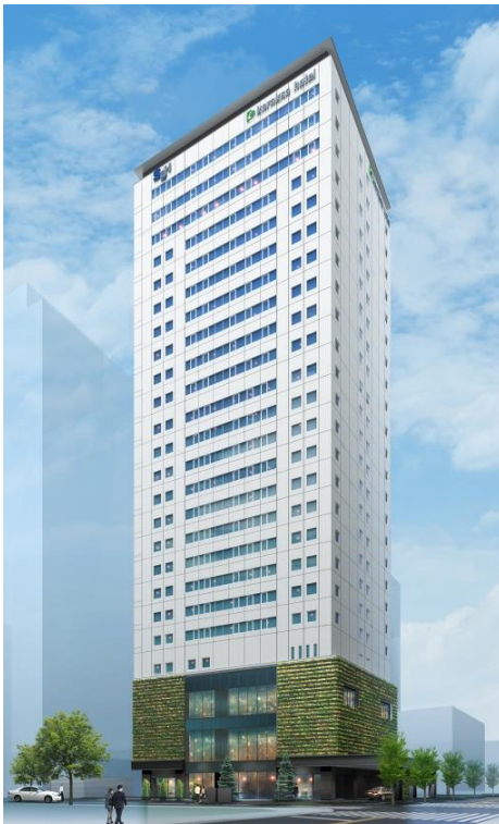
ホテル外観：24 階建て・全 396 室
